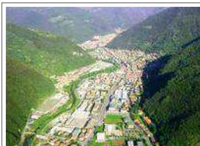
L'autostrada della Valtrompia dovrà attendere fino al 2018
