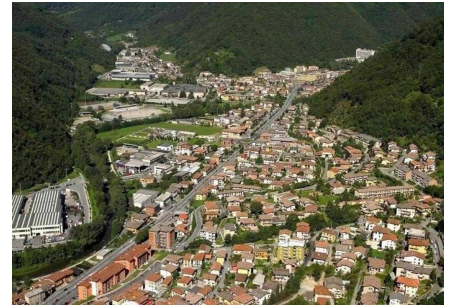
Autostrada della Valtrompia: accordo raggiunto, ma manca la firma
