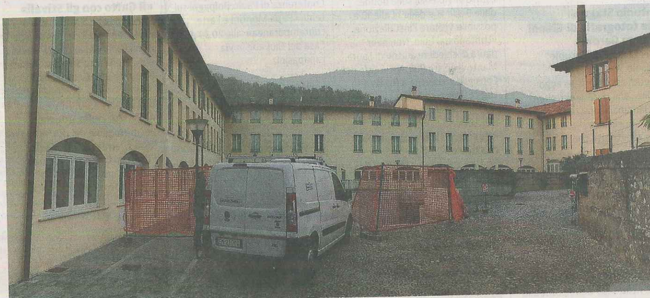
A San Vigilio. Lo storico complesso residenziale vanta 42 appartamenti con cantine e posti auto interrati
